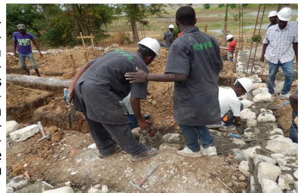
Étudiants travaillant sur les fondations du bâtiment de l'IFV.
